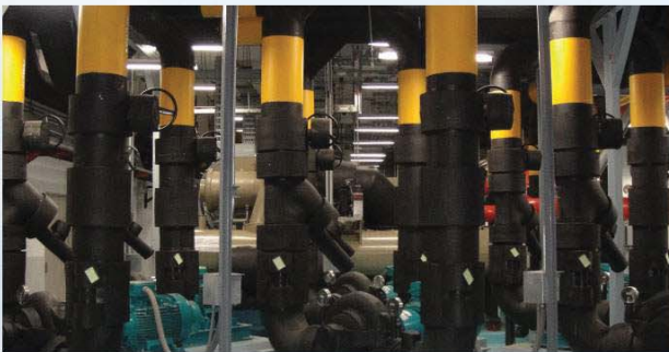
แอโรโฟล็กซ์มีคุณสมบัติดับไฟได้เอง มีความยืดหยุ่นสูงและง่ายต่อการติดตั้ง ฉนวนแอโรโฟล็กซ์ จึงเป็นฉนวนที่เหมาะสมกับอาคารต่างๆ เนื่องจากความปลอดภัยและช่วยป้องกันปัญหาหยดน้ำร้อน
