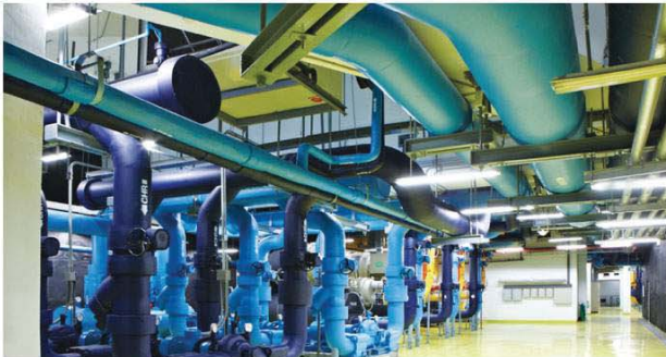
ค่าสัมประสิทธิ์การนำความร้อนต่ำค่าที่ มีการดูดซึมน้ำและการแทรกซึมของไอน้ำที่ต่ำ ทำให้ฉนวนแอโรโฟล็กซ์ใช้ในระบบท่อน้ำเย็นกันอย่างแพร่หลาย
