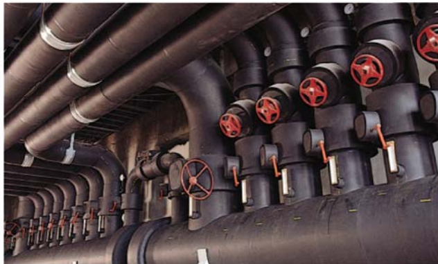
แอโรฟлексมีคุณสมบัติดีไปได้อีก มีความยืดหยุ่นสูงและง่ายต่อการติดตั้ง ฉนวนแอโรฟлексจึงเป็นฉนวนที่เหมาะสมกับอาคารต่างๆ เนื่องจากความปลอดภัยและช่วยป้องกันปัญหาหยดน้ำของท่อน้ำเย็น
